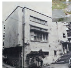
かつての意匠設計研究室アトリエ ● 右下の階段だけが「純粹階段」として現存する
