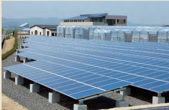
シリコン型太陽光パネル。自家発電した電気は、農業施設や本館の電気、空調、研究用電源に使用する
